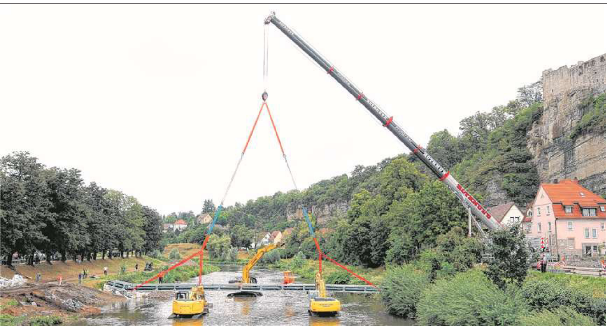
Am Haken eines 350-Tonnen-Krans über die Enz schwebend: die knapp 14 Tonnen schwere Düker-Konstruktion mit Versorgungsleitungen für den Stadtteil Dürrmenz.
