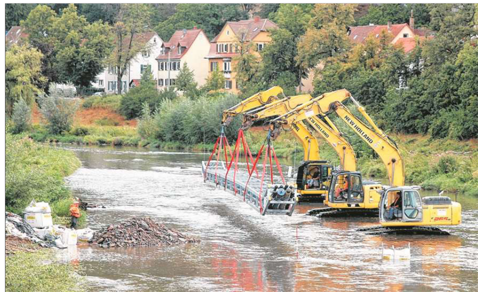
Das könnte die Premiere eines „Synchron-Baggerns“ gewesen sein: Die drei Baumaschinen transportierten die Konstruktion von der Dürrmenzer Enzseite zur anderen.
