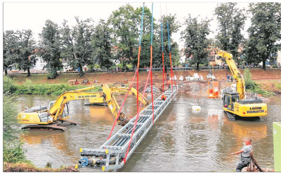
Das könnte die Premiere eines „Synchron-Baggerns“ gewesen sein: Die drei Baumaschinen transportierten die Konstruktion von der Dürrmenzer Enzseite zur anderen.
