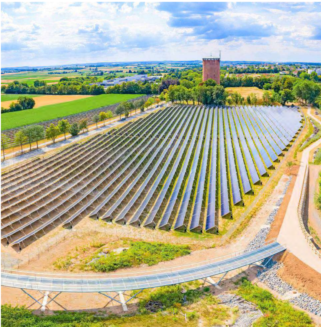
Die Solarthermieanlage der Stadtwerke Ludwigsburg-Kornwestheim ist ein Baustein bei der Wärmeversorgung der Kommunen. FOTO: KARSTEN SCHMALZ
